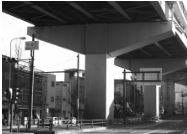
図 1.1-4-1 高架橋の T 型 RC 橋脚の例
